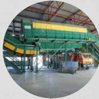
DREHSIEBANLAGEN UND SAMMLUNG UNTER DER SIEBANLAGE
