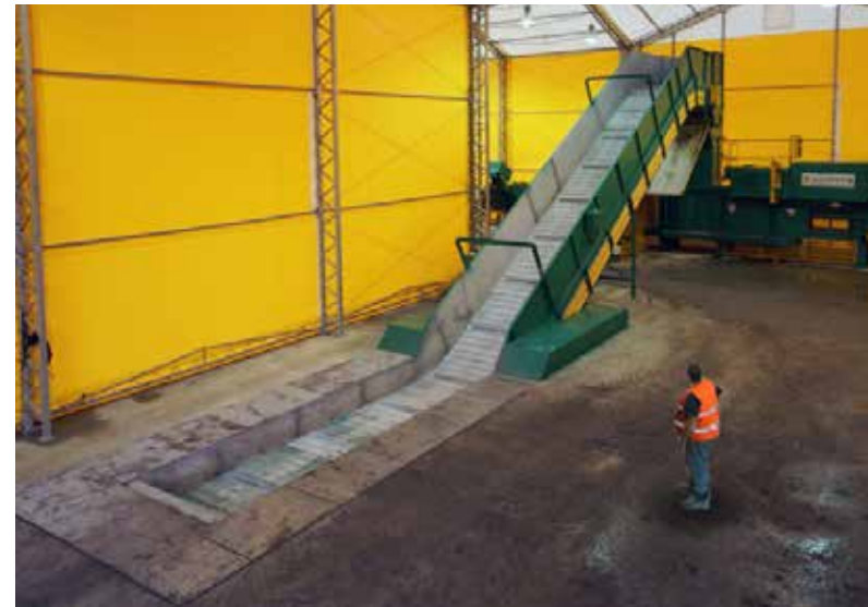
UNTERFLUR-LADEBEREICH (MIT VERTIEFTEM SCHACHT)
