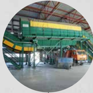
DREHSIEBANLAGEN UND SAMMLUNG UNTER DER SIEBANLAGE
